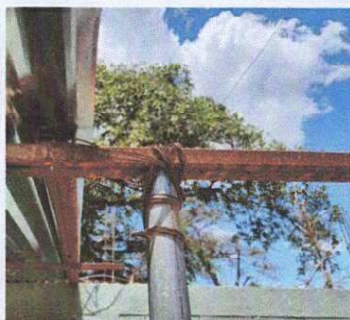
Foto 1: Sustrucción de estructura portante galvanizada con tubería de 4x4 y portalamina de 2x3 en área de patio y área a la par de la cocina
