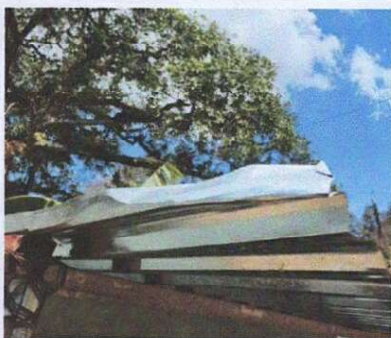
Foto 3: Sustrucción de lámina troquelada de aluzinc calibre 26 incluye tornillería en área de patio
