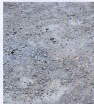
Foto 2: Reparación de losa de concreto de 0.08 cms de grosor en área de patio
